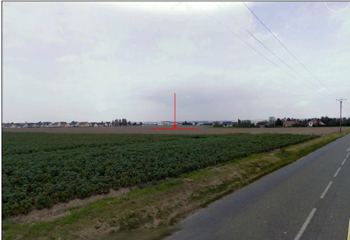
Vue de la RD 97 en venant de BOVELLES (2014)
